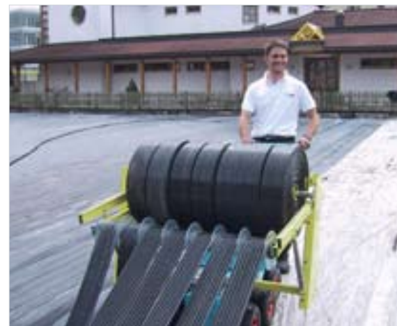
Srotolamento dei tappeti di refrigerazione
